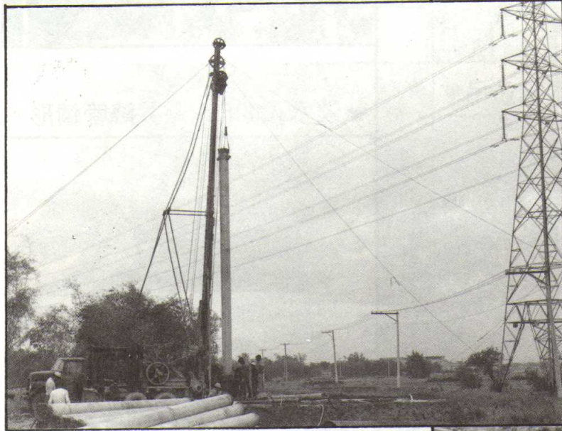
▲彰化第三水源地 \phi 400 FRP300公尺 深井施工情形。
