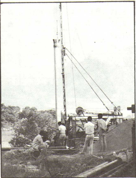
▼淡水 \phi 300 FRP深井降管情形。
