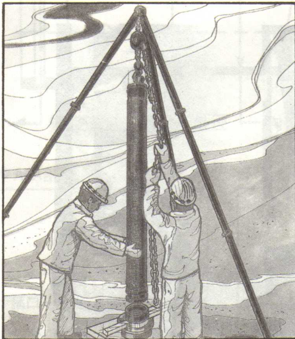
▲下降井管，使一端承口向上
