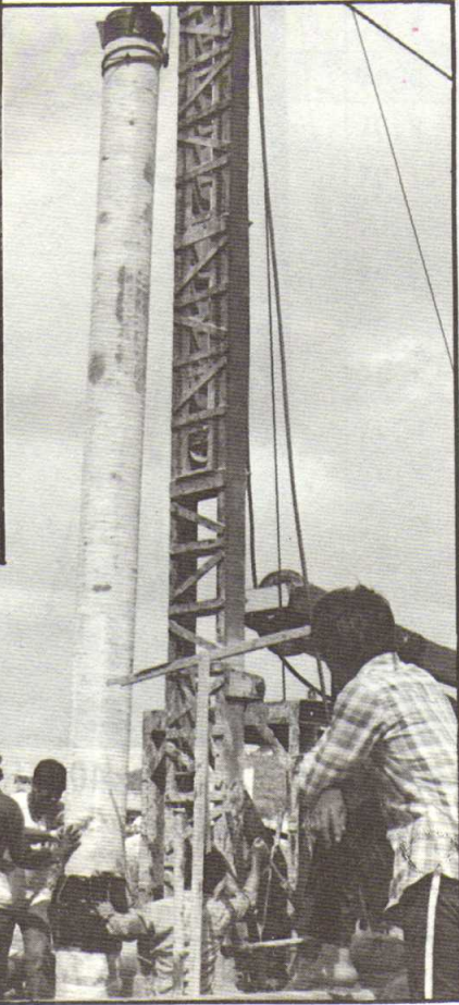
淡水 \phi 300 FRP深井接頭接 合降管情形。
