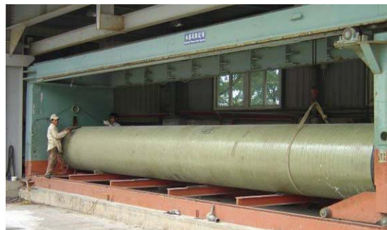
42" 海水管靜水壓測試情形
