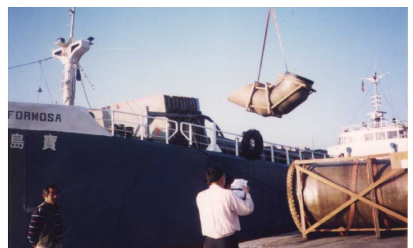
海口電廠 1800m/m 海水循環管裝船
