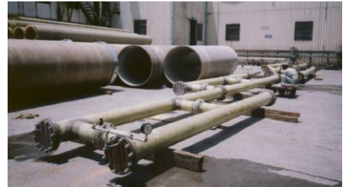
海水輸送歧管靜水壓測試情形
