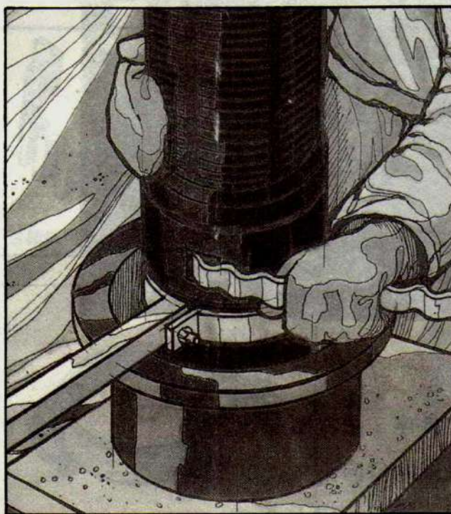
▲插口插入承口後，以鎖條鎖入鎖條溝
