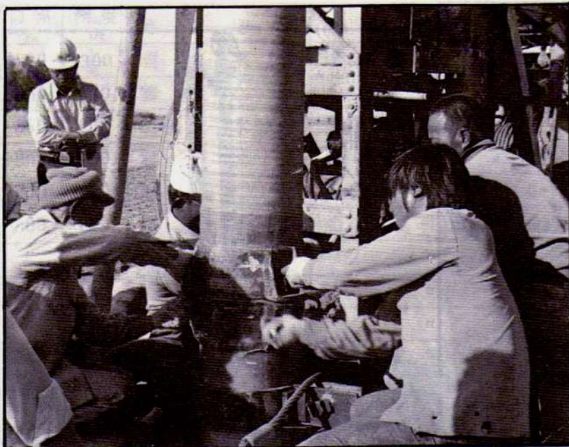
▲雲林水林 300公尺深井接頭施工情形。
